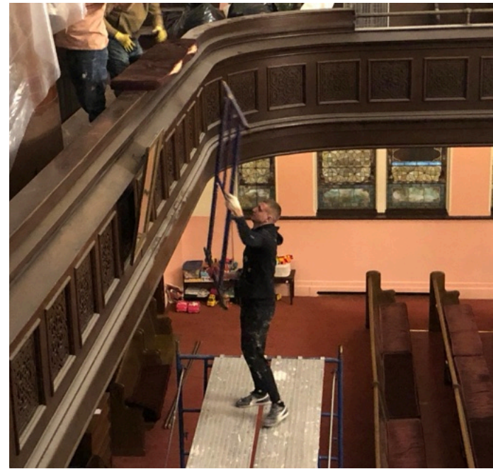
Завершення ремонту балкона
